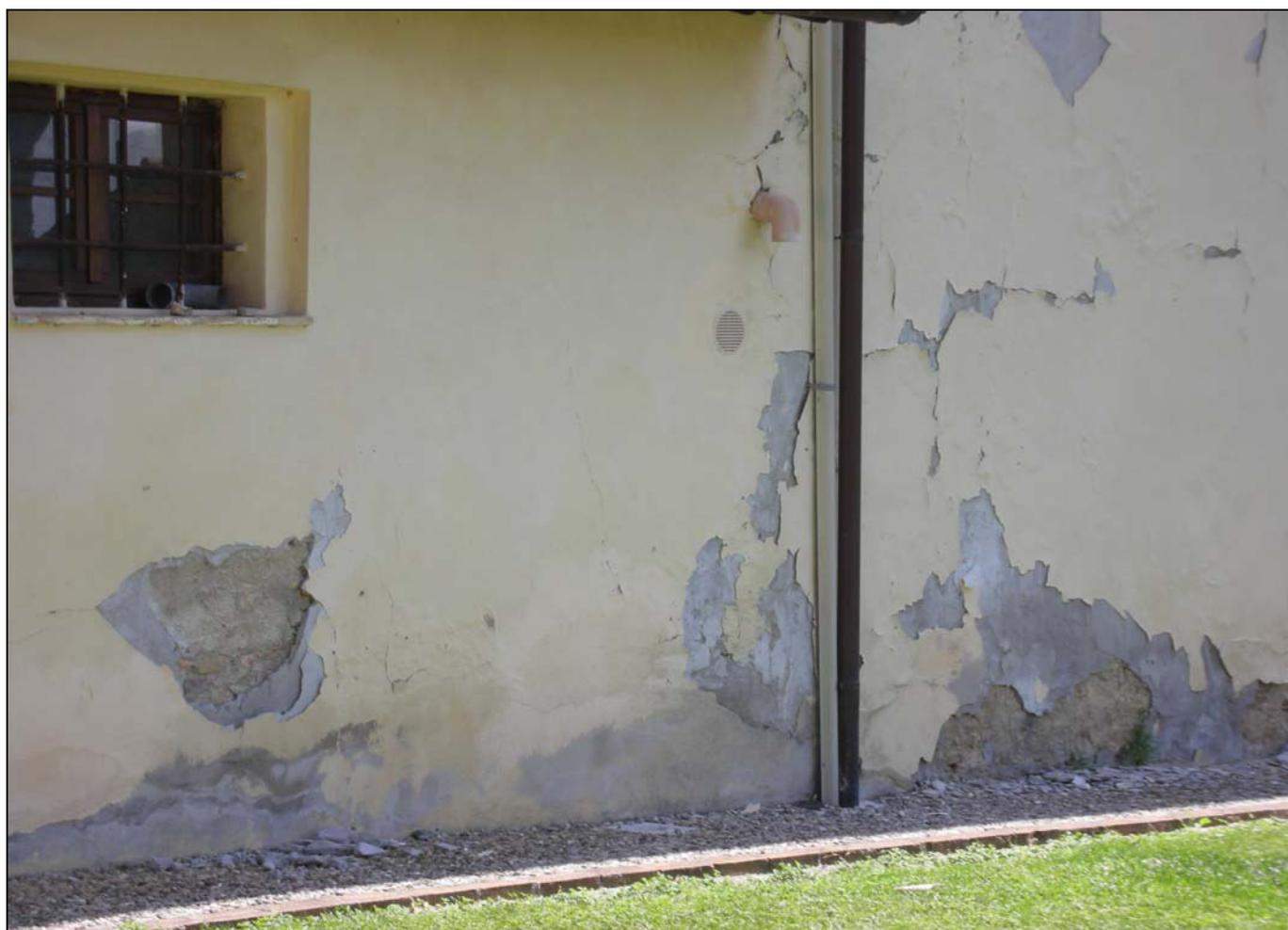
*Foto 7 – particolare distacco intonaco su prospetto Ovest*
