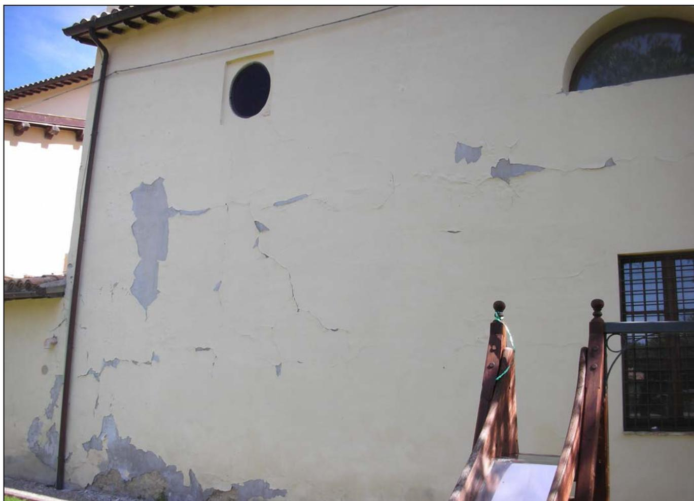
*Foto 8 – particolare distacco intonaco su prospetto Ovest*
